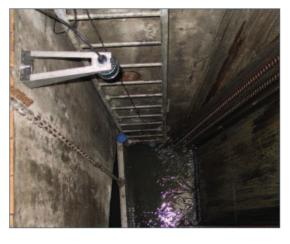
**BLOCKED CHUTE DETECTION OVER 1.2m**
